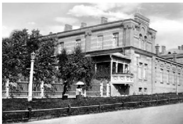
Дом приамурского генерал-губернатора. 1897
